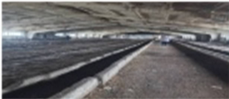
Навес неустановленного назначения д. Мордахи 1979 г.
